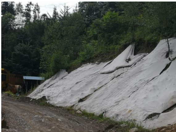
边坡临时遮盖
