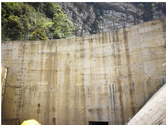
排土场区挡土坝
