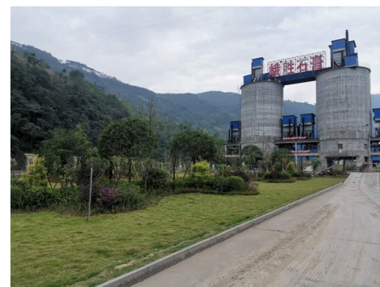
堆料场区水土保持措施
