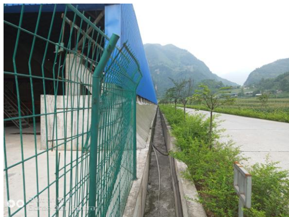
堆料场区排水沟
