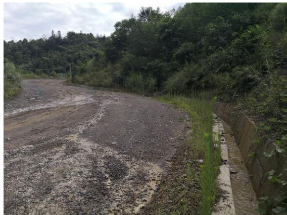
矿区道路排水沟
