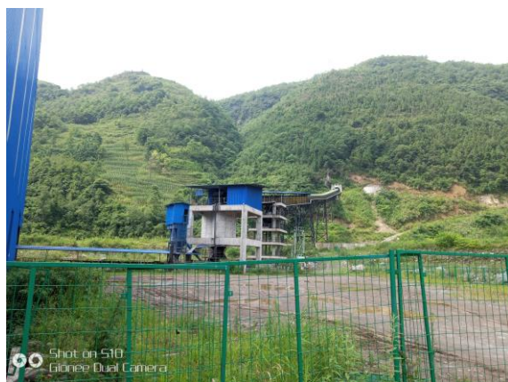
堆料场区绿化（中间为硬化场地）
