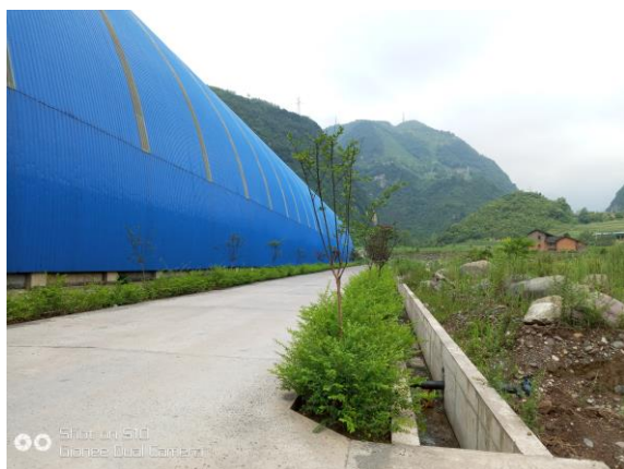
堆料场区排水沟
