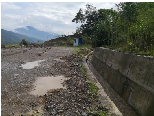
矿区道路排水沟
