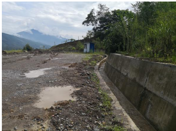
矿区道路排水沟
