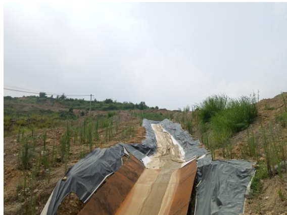
排土场区临时排水沟土工布
