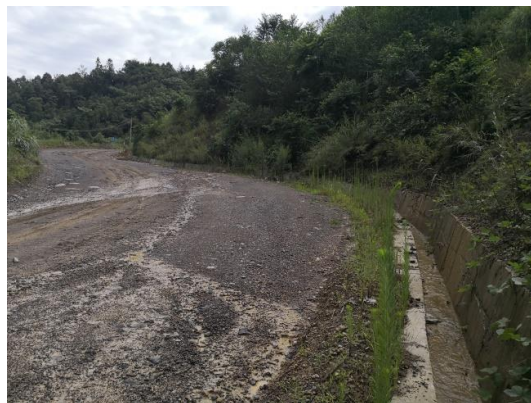
矿区道路排水沟
