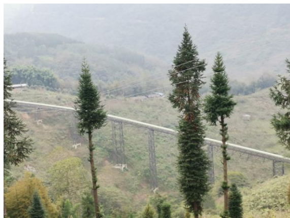
运输皮带迹地恢复
